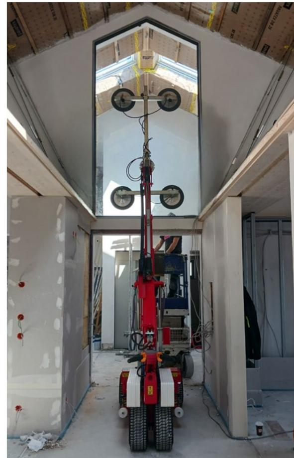
3D Glasmanipulatoren wie der funkgesteuerte und elektrische Sky Lifter von Smartlift arbeiten ohne Einschränkung der Arbeitshöhe. Die Maschine – ein Mobil-, Mini- oder Ladegerät – an dem der Glasmanipulator befestigt ist, kommt als Glasmontagekran zum Einsatz. Die Vakuumsauger sind teleskopierbar und ermöglichen so die Außen- wie auch Innenverglasung. Eine hydraulische Bedienung erfolgt punktgenau per Funkfernbedienung.
